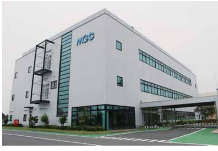
安全操業とクリーンな工場運営を追求 (写真は統合管理センター)
